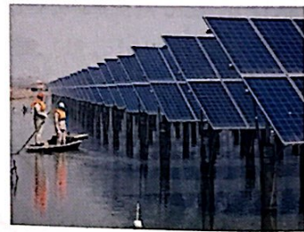
a. 桩基固定电站
